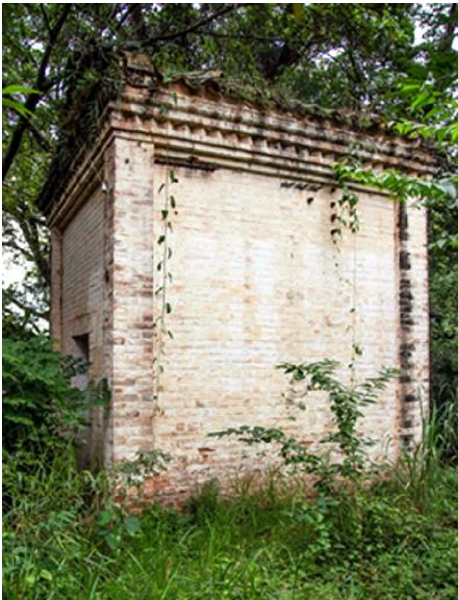
Figura 12 – Fachada frontal e lateral da Casa de Força. Fonte: Acervo de Wânia Bertinato. Data: abr. 2024.
